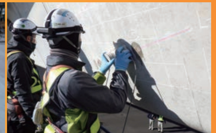
調査状況 既設PC橋
