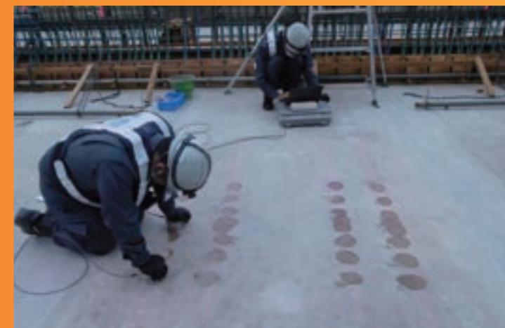
調査状況 新設PC橋
